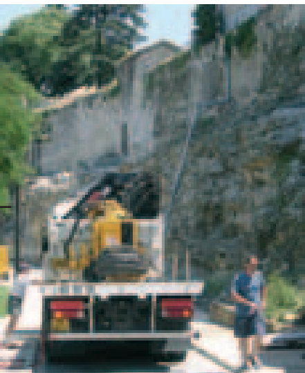
Après consultation, c'est la Société niçoise "Heaven Climber" qui a été chargée de ces travaux très particuliers.
